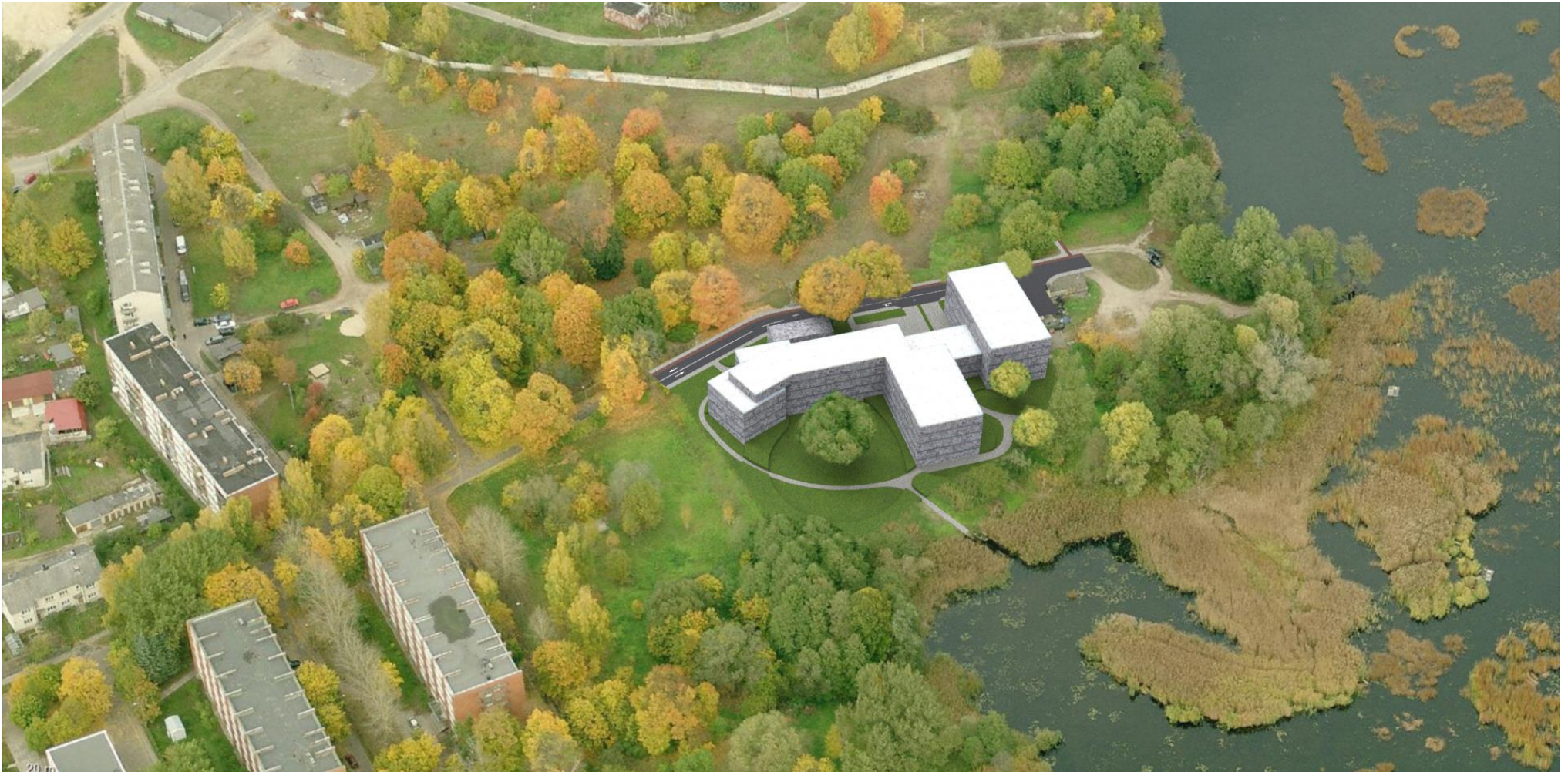
Skats no dienvidu puses (virzienā no Lorupes ielas).
